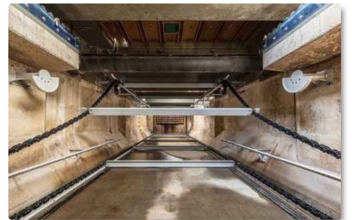
実機設置状況
