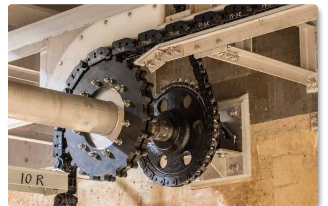
駆動軸設置状況
