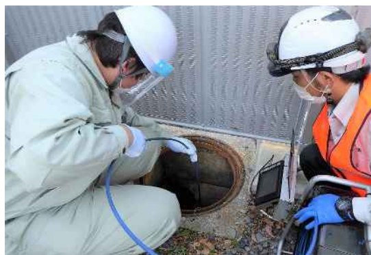
下水取付管TVカメラ調査実習
