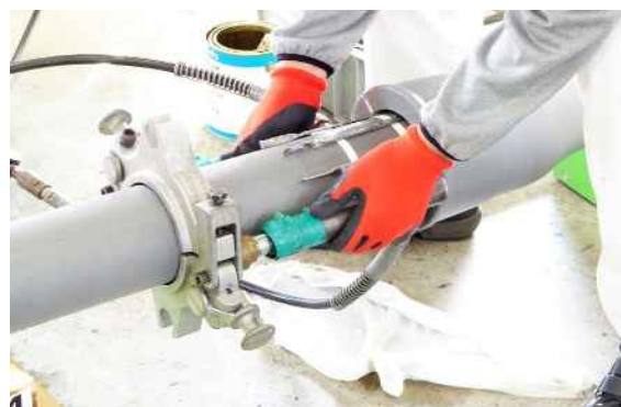
GX形継手解体実習
