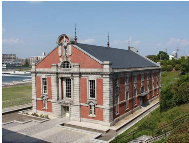
鍋屋上野浄水場
