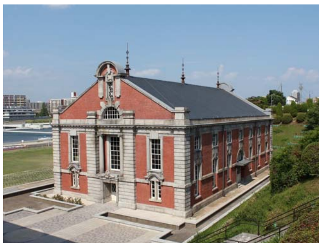
鍋屋上野浄水場 (旧第一ポンプ所)
